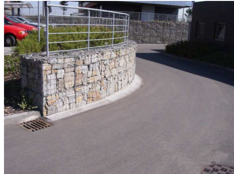
REFERENCE UŽITÍ GABIONOVÉ STĚNY
