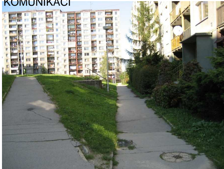
NEVYHOVUJÍCÍ STAV PĚŠÍCH KOMUNIKACÍ
